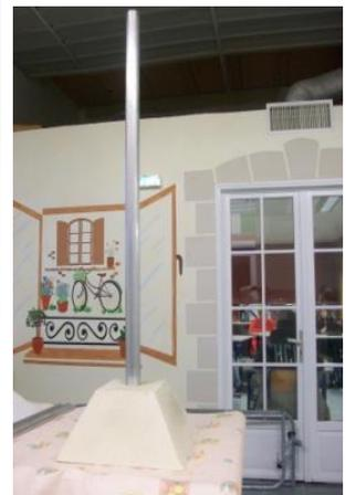
Le coffrage doit être parfaitement de niveau lors du coulage du Béton afin de permettre au tube de fixation d'avoir le meilleur aplomb possible.
