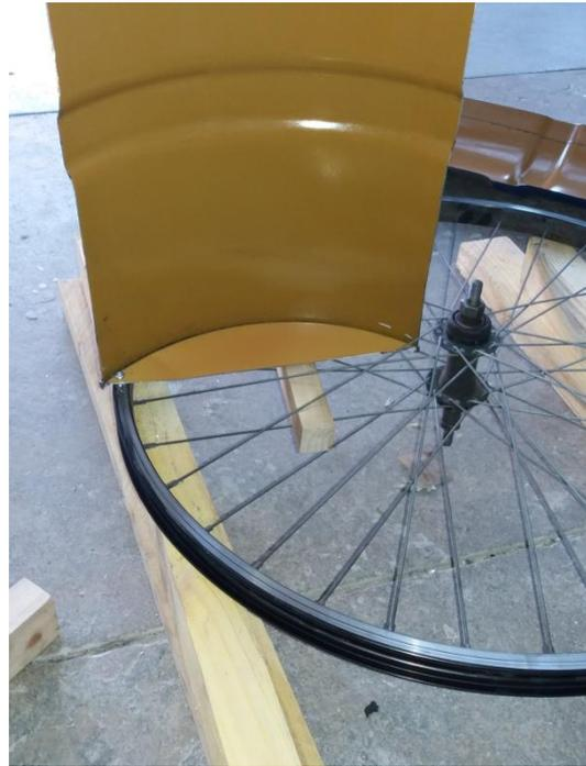
**Calage de la pôle entre les rayons (côté axe de roue) et vissage sur la jante (vis auto foreuse)**
