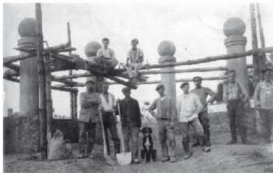
photo 3 - vue du nord du cimetière 1, construction du portique d'entrée. Carte datée du 05/08/0916.
