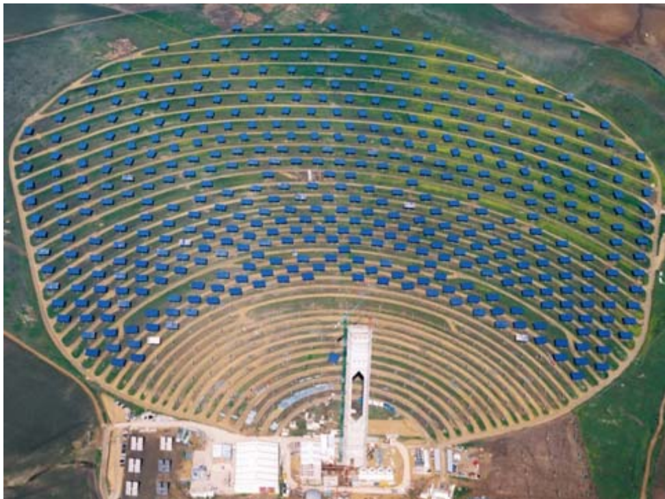
Figure 8 – Vue aérienne de la centrale PS10
