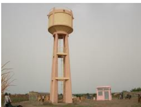
Photo : Un château d'eau (avec l'autorisation de la Fondation Veolia Environnement)
