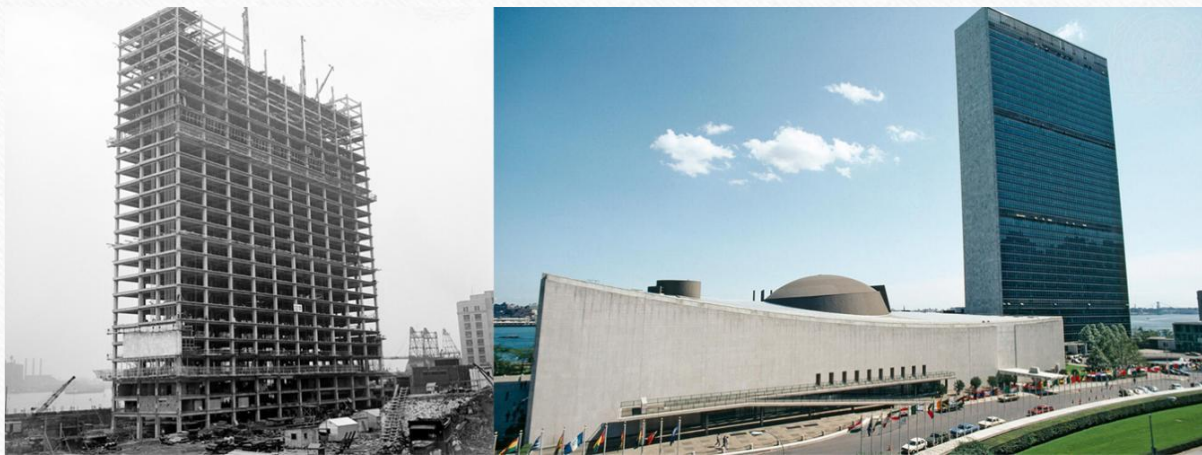
Le bâtiment du Secrétariat de l'ONU (à gauche) en cours de construction à New York en 1949. À droite, les bâtiments du Secrétariat et de l'Assemblée générale quatre décennies plus tard, en 1990. Photo ONU: MB (L); UN Photo (R)
