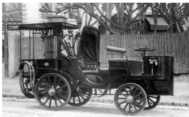
Photo de La Mancelle , réalisée en 1878.
