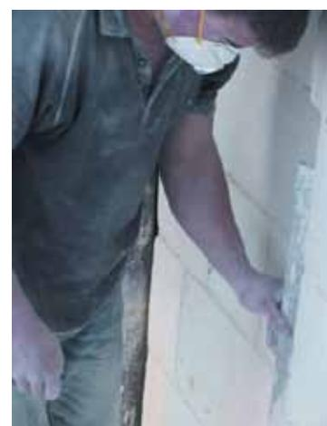
Vérification de la planéité au moyen d'une règle
