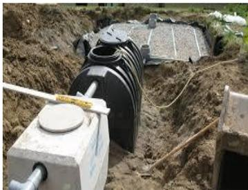
Réseaux de collecte des eaux vannes et ménagères, comportant : fosses toutes eaux 3 m<sup>3</sup> ; bac à graisses ; drains d'épandage ; regards de visite...
