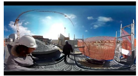
Chantier en visite virtuelle 360°
