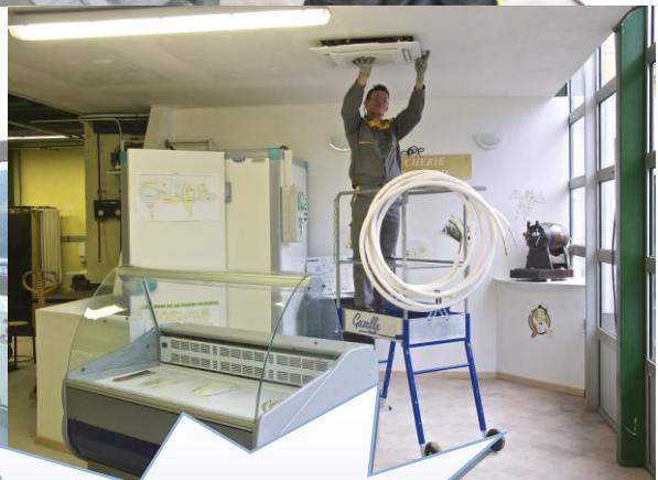
Pose de l'unité de climatisation pour la boucherie
