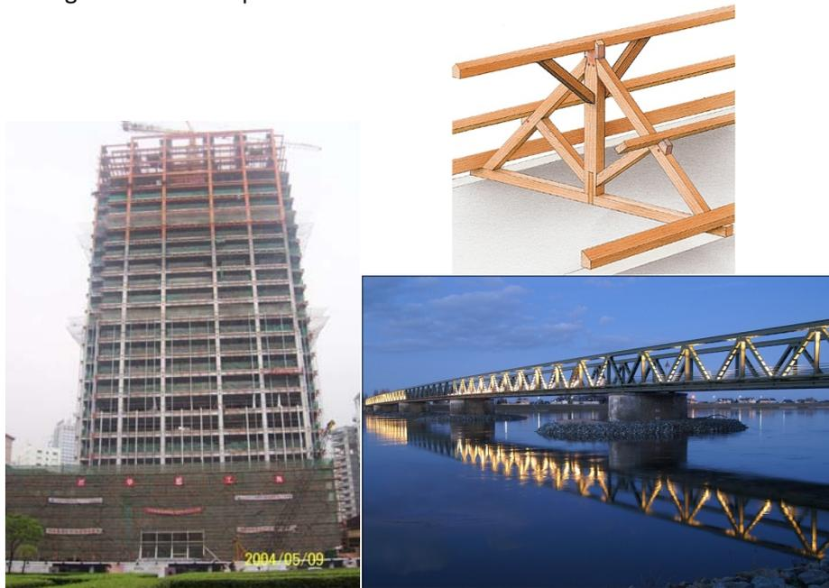
Ce choix vient de ce que – et cela se constate expérimentalement de façon très simple – les pièces résistent bien plus facilement à une sollicitation en traction ou en compression qu'à une sollicitation en flexion.
